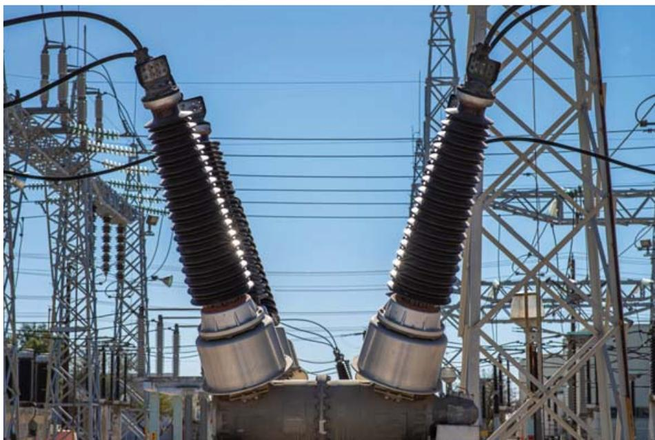
➤ Utilisé notamment dans les transformateurs haute tension, le SF6, s'il procure de nombreux avantages, a un vrai inconvénient : c'est un puissant gaz à effet de serre.
