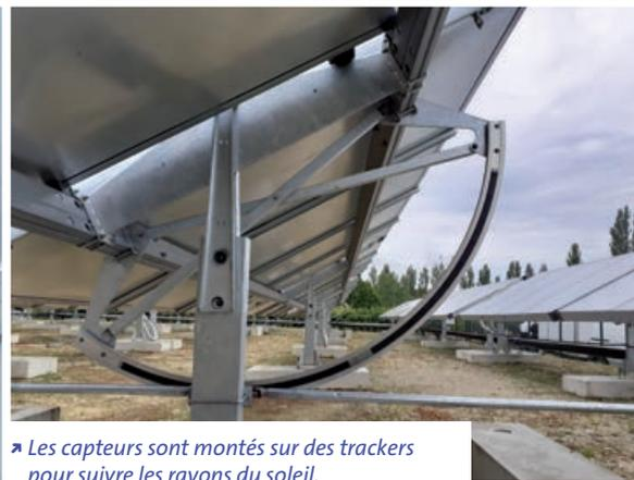
➤ Les capteurs sont montés sur des trackers pour suivre les rayons du soleil.
