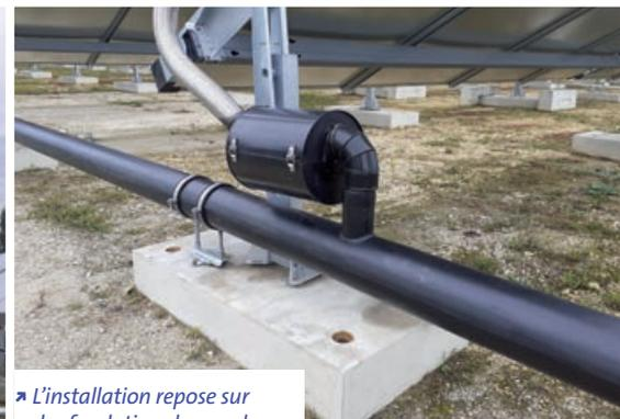
➤ L'installation repose sur des fondations hors-sol pour préserver des restes archéologiques souterrains.
