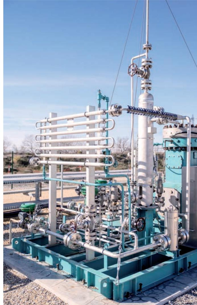
➤ Un compresseur hydrogène avant injection au réseau de transport de gaz.
