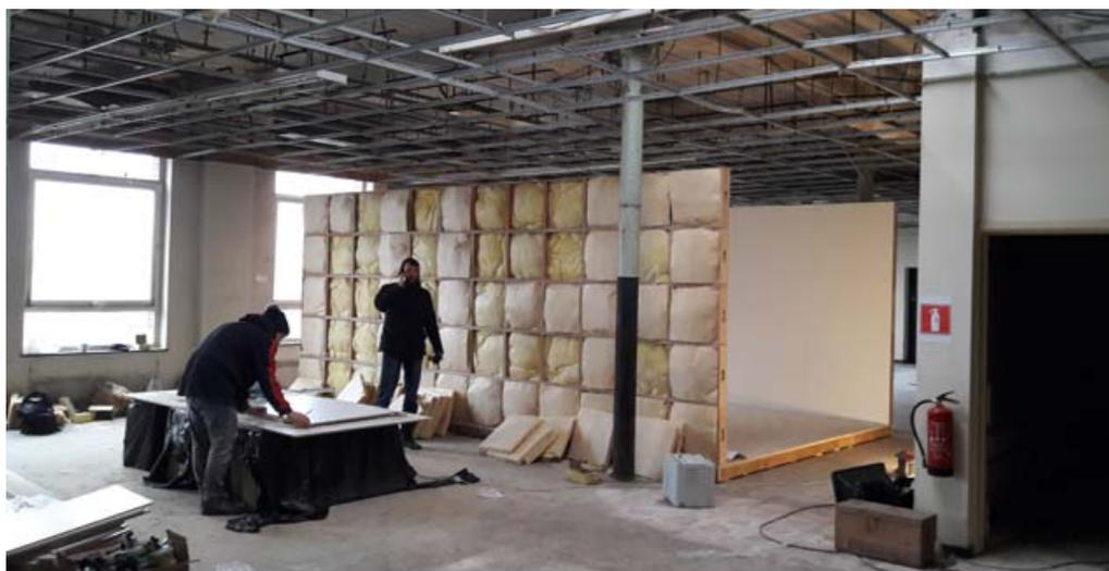
► Sur le projet Citygate, des matériaux d'isolation ont été réutilisés pour construire les modules «BeModule».
