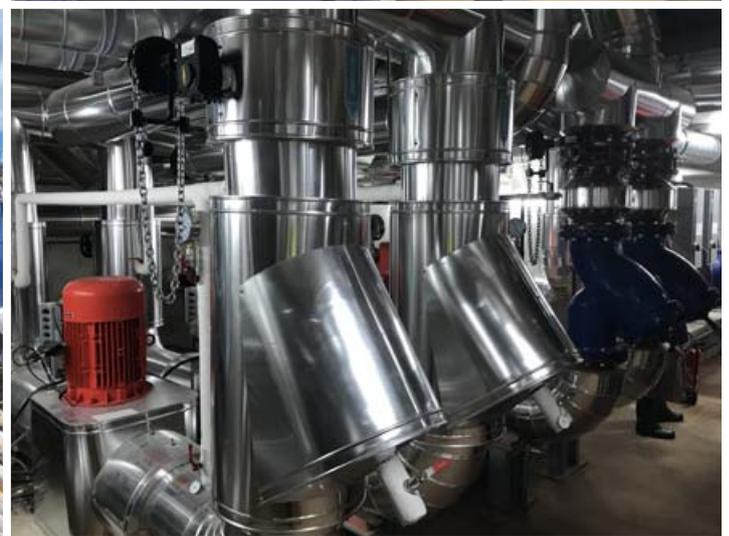
► Le système puise par l'intermédiaire de quatre puits à 35 mètres de profondeur une eau dont la température oscille entre 14 °C et 16 °C.
