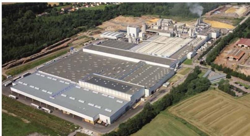
► Située dans les Vosges, le site de Rambervillers d'Egger Panneaux & Décors est équipé d'une chaudière biomasse de 55 MW. Cette chaudière alimente le site en chaleur et également en vapeur une turbine de cogénération de 9 MW.
