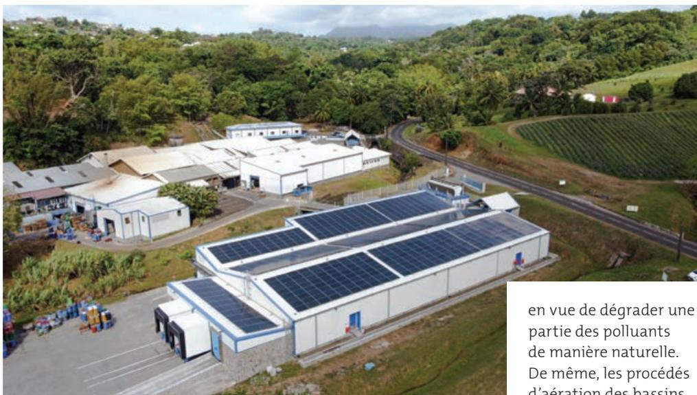
← L'installation de panneaux solaires photovoltaïques, en autoconsommation, a permis de couvrir 14% des besoins électriques du site.
