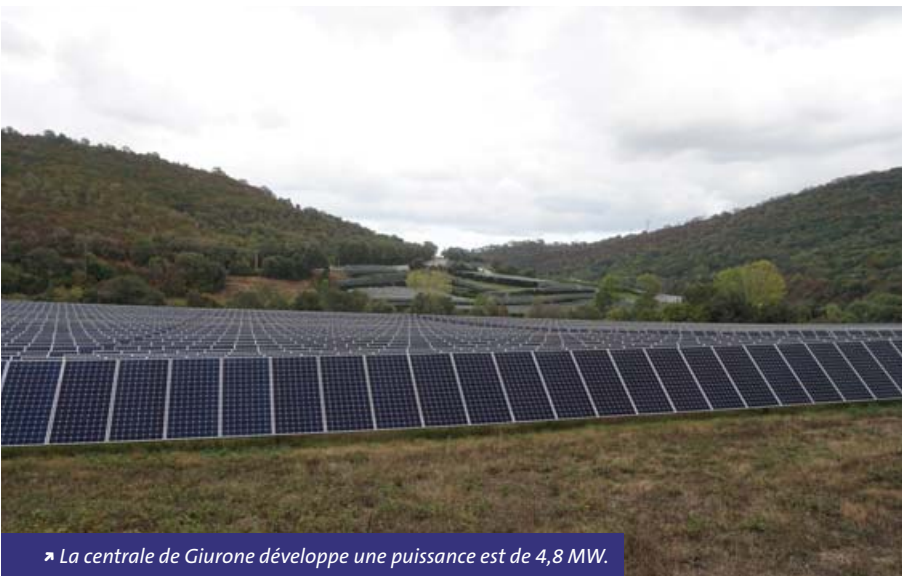
→ Les panneaux photovoltaïques sont montés sur des trackers.
