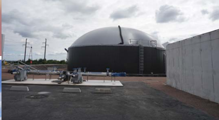
➤ Le digesteur de 4 250 m 3 est associé à un post-digesteur du même volume.
