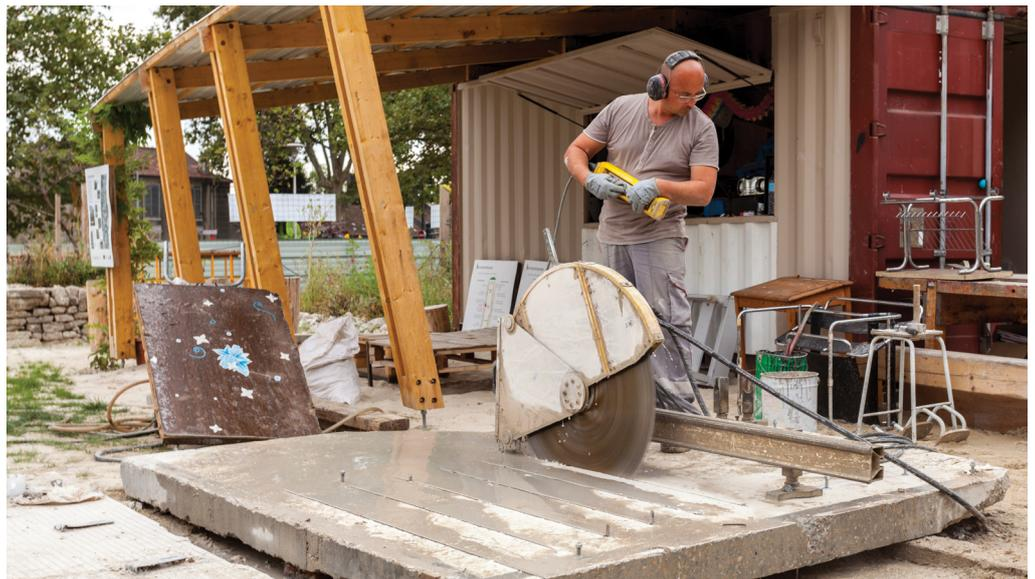
► *Plusieurs prototypes de réemploi à partir de béton ont été créés, notamment des maçonneries paysagères, des revêtements de sols, et même des locaux non chauffés.*
