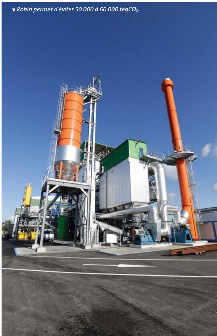
▸ La vapeur est générée à 32 bars et à une température de 275 °C.
