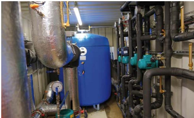
↖ Un ballon de stockage d'eau chaude et une station de pompe pour le dégivrage de la chambre froide négative.
