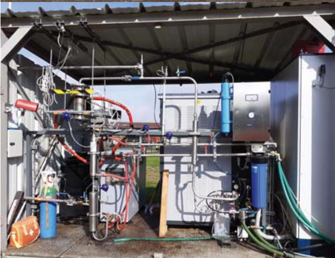
➤ Le CO 2 biogénique est mélangé à de l'hydrogène produit par électrolyse pour créer du e-méthane.
