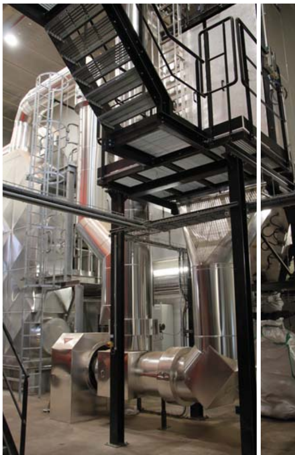
➤ La chaufferie est couplée à un récupérateur de chaleur sur les fumées.
