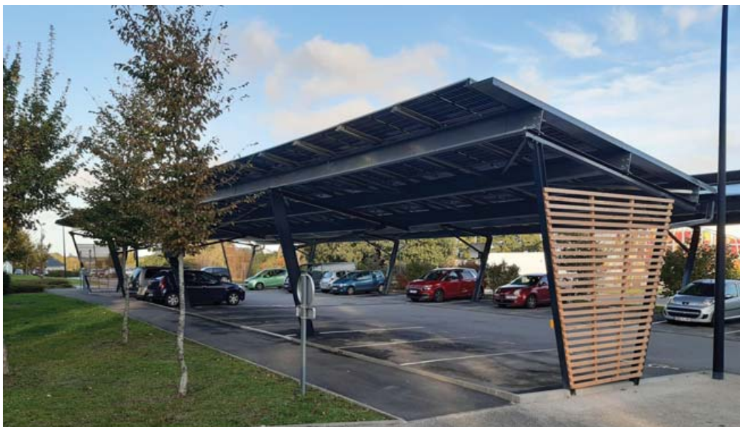
▀ Les ombrières photovoltaïques ont été posées sur le parking du Sydela.
