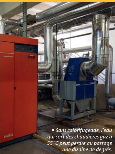
↳ Sans calorifugeage, l'eau qui sort des chaudières gaz à 55 °C peut perdre au passage une dizaine de degrés.
