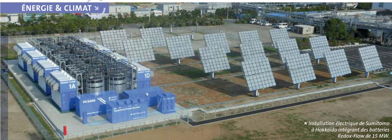
Installation électrique de Sumitomo à Hokkaido intégrant des batteries Redox-Flow de 15 MW.
