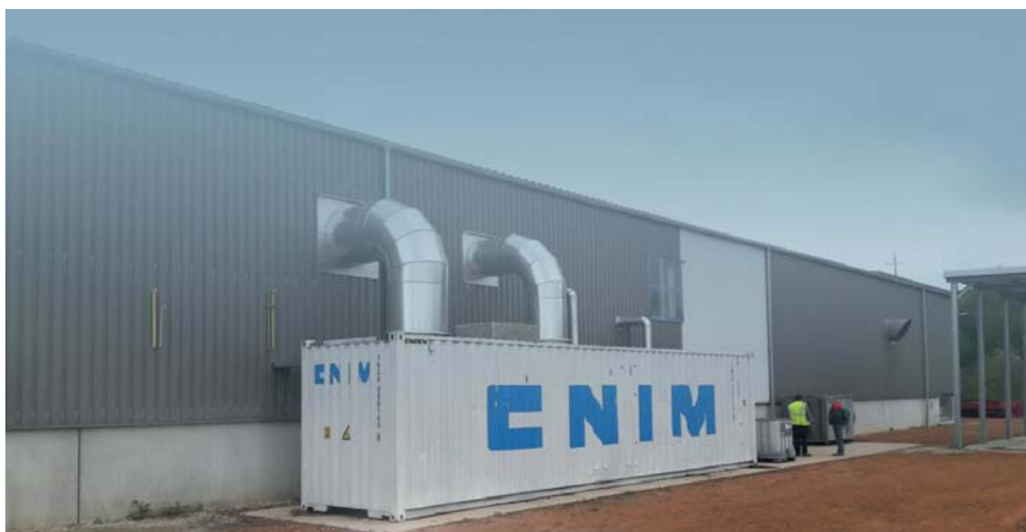
La société CNIM a fourni une pompe à chaleur à absorption au groupe autrichien Wienerberger, fabricant de briques et de tuiles.
