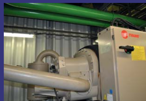
Une quatrième unité de production de froid (1 MW en positif et 800 kW en négatif), sur dry cooler (aéroréfrigérant sec), complète l'installation.
