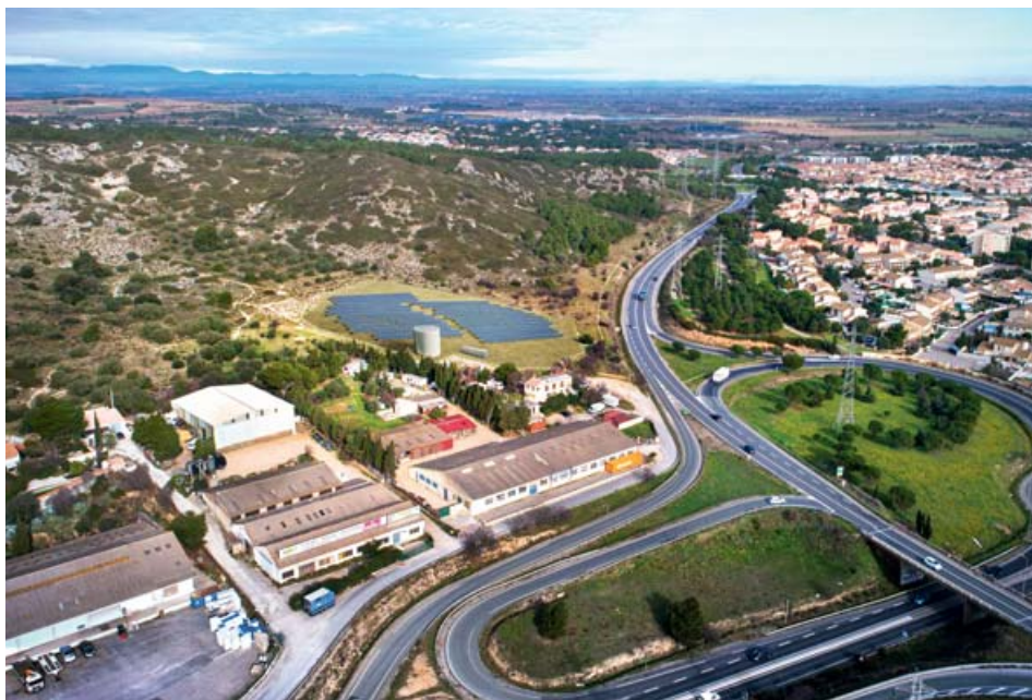
La centrale solaire sera raccordée au bout d'une branche du réseau de chaleur actuel et mise en service d'ici la fin de l'année.
