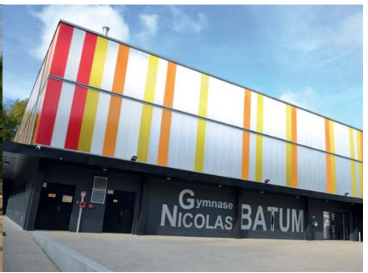
► Le gymnase Nicolas Batum pendant et après sa rénovation globale en 2013.
